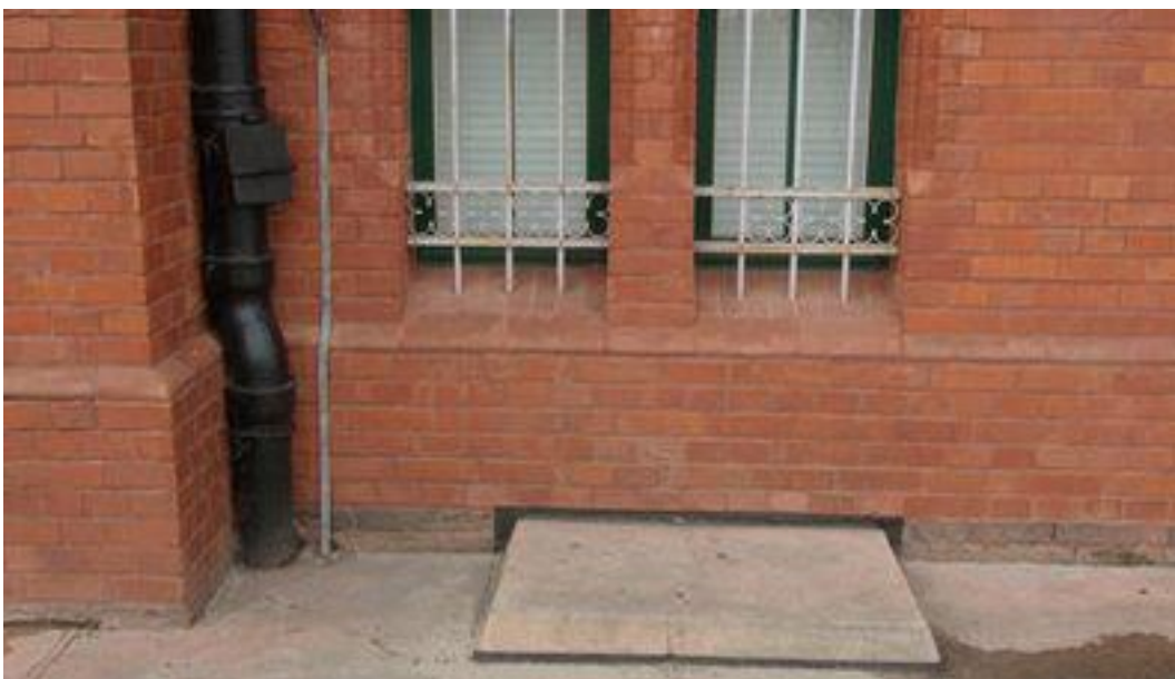
Zdj. nr 13 Zabetonowany świetlik.
