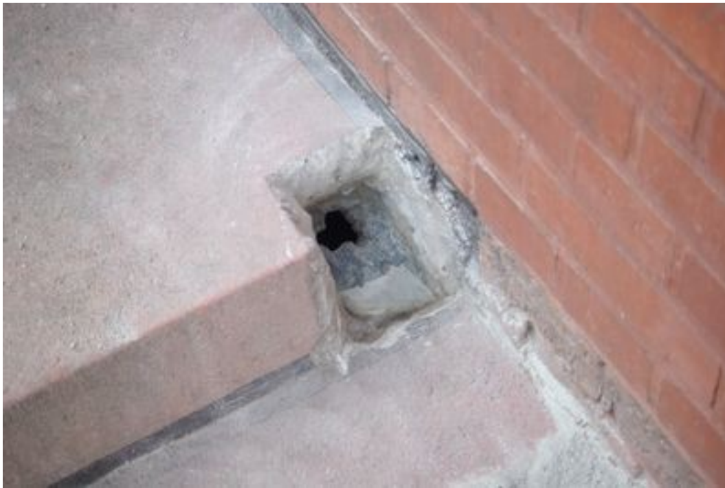
Zdj. nr 14 Odkrywka przy betonowej czapce świetlika.
