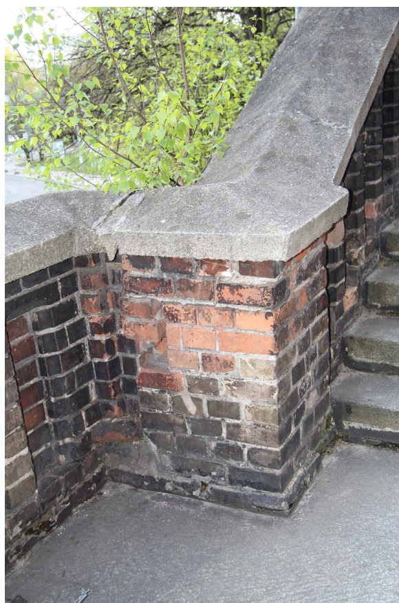
Zdj. nr 7 Balustrada przy spoczniku środkowym schodów. Odchylenie balustrady na skutek odpychania jej przez płyty niezdyktowane płyty granitowe spocznika, spowodowało pęknięcie o szer. 2,5 cm. Zamarzająca woda w spoinach i pod płytami spocznika również tworzy nacisk na ściankę balustrady powodując jej odchylanie się od pionu.
