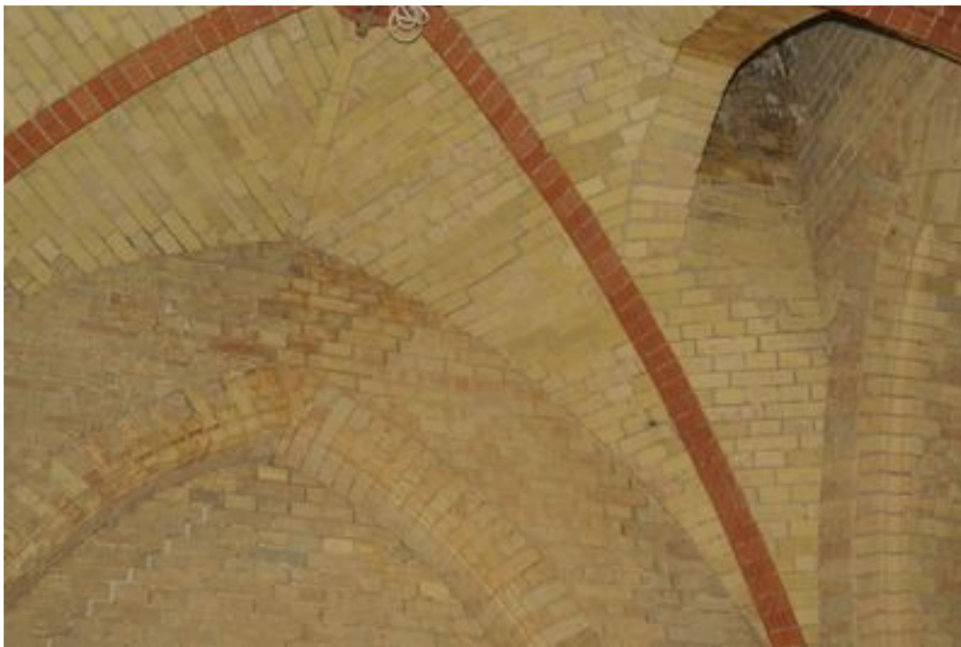
Zdj. nr 15 Fragment sklepienia. Widoczne zacieki od strony świetlika.
