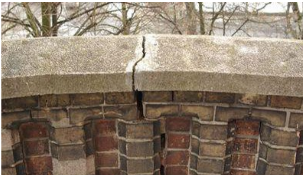
Zdj. nr 6 Balustrada przy spoczniku górnym schodów. Przesunięcie 2 cm. Czapka balustrady betonowa.
